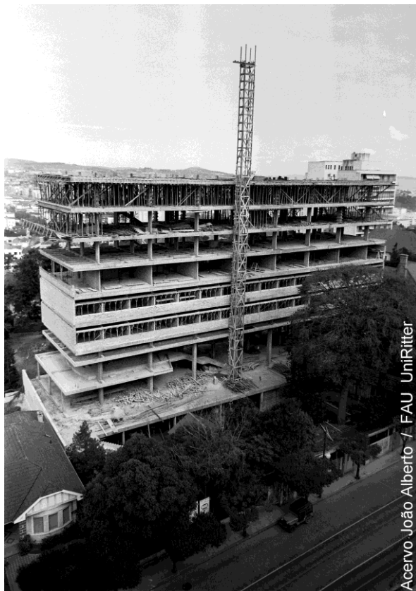
Figura 4 – Hospital Fêmeina em construção. Fonte: Acervo João Alberto Fonseca da Silva.
